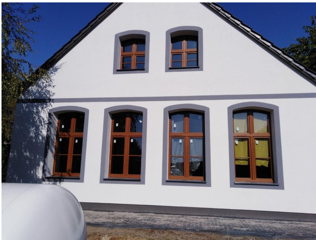
Fot. 3. Archiwum projektu. Budynek szkoły po remoncie.
