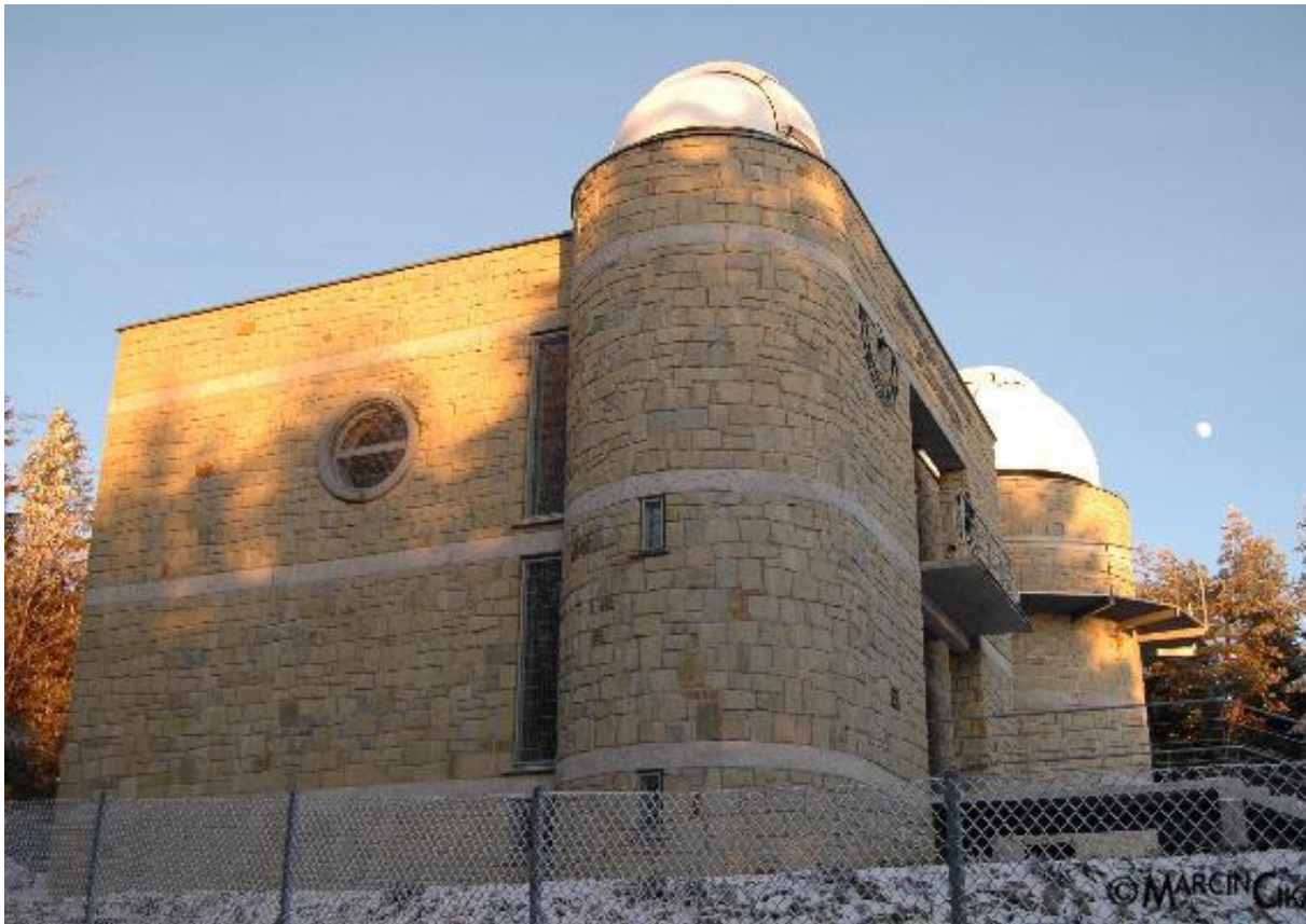
Fot. 4. Odbudowany główny budynek obserwatorium.
