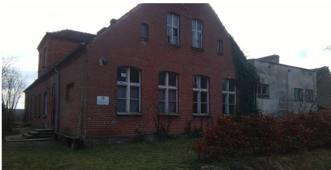
Fot. 1. Archiwum projektu. Budynek szkoły przed remontem.
